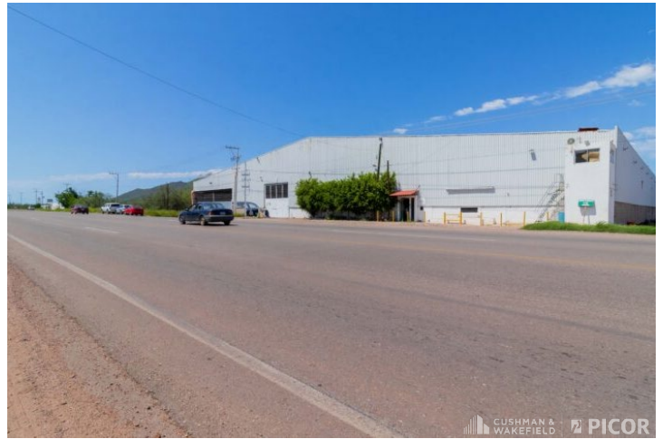
Edificio Sobre Via Principal
